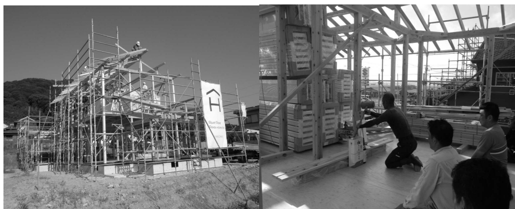
棟上げ式の様子
