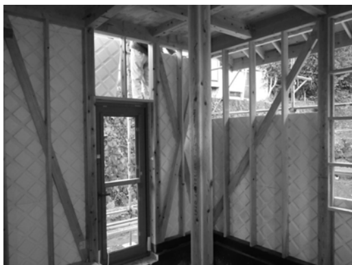
進行中の現場の様子
