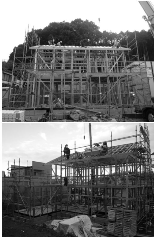
棟上げの様子
